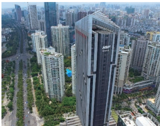
海南省农垦投资控股集团有限公司总部大楼
